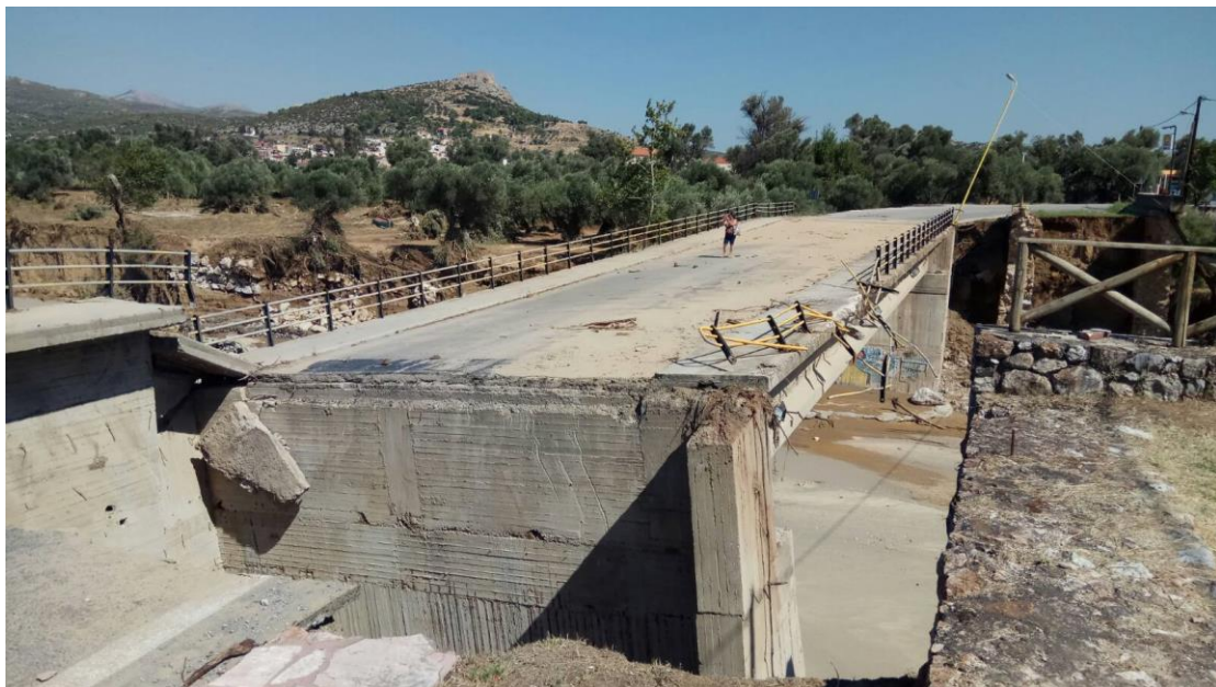
Εικόνα 17: Βλάβες σε γέφυρα από οπλισμένο σκυρόδεμα στην περιοχή του Αφρατίου μετά την πλημμύρα του 2020 στον Λήλαντα. (Πηγή: ΕΚΠΑ 2021).
