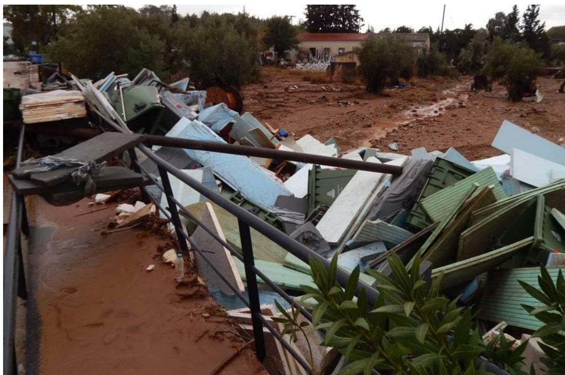
Εικόνα 11: Αποψη γέφυρας την πόλη της Μάνδρας, στην οποία αποτυπώνονται όγκοι φερτών υλικών ανθρωπογενούς προέλευσης αλλά και φυσικών τα οποία συσσωρεύθηκαν μειώνοντας κρίσιμες διατομές των υδατορευμάτων σε πολυάριθμες θέσεις της Μάνδρας κατά τη διάρκεια της πλημμύρας του 2017, αλλά και σε άλλες περιπτώσεις στον Ελληνικό χώρο. (Πηγή φωτογραφίας: Δεληγιαννάκης Γ., 2017).
