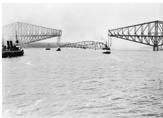
Εικόνα 34: Η γέφυρα μετά την πτώση του κεντρικού τμήματος το 1916 (πηγή: www.wikipedia.org )
