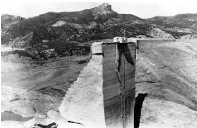
Εικόνα 35: Το φράγμα St. Francis πριν τη θραύση του (πηγή: www.michanikos.gr )
