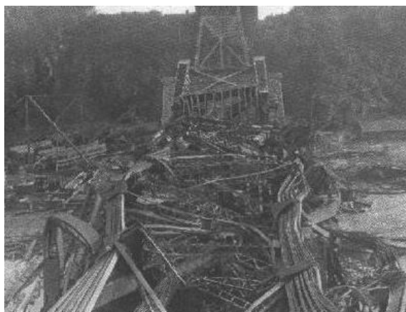
Εικόνα 33: Τα συντρίμμια της γέφυρας μετά την κατάρρευση του 1907 (πηγή: www.wikipedia.gr )
