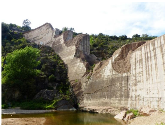
Εικόνα 38: Τα εναπομείναντα συντρίμια μετά τη θραύση του φράγματος (πηγή:
