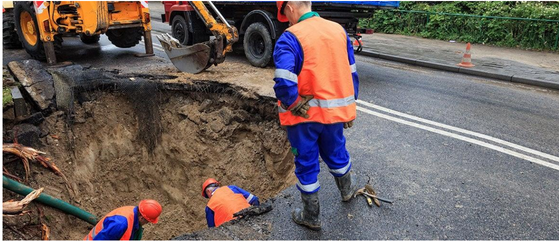
Εικόνα 60: Εργασία εκσκαφής Πηγή: istockphoto.com
