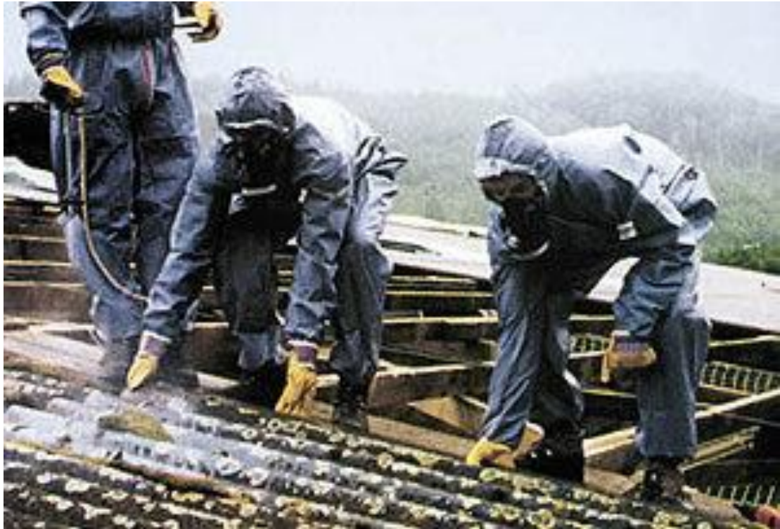
Εικόνα 56: Πραγματοποίηση εργασιών που εμπεριέχουν αμίαντο (Πηγή: suk.gr).
