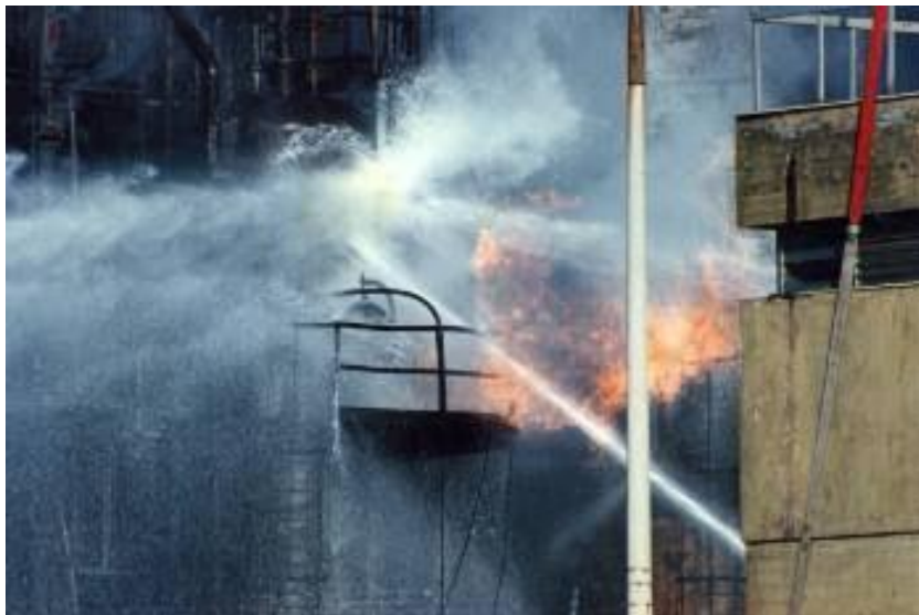
Εικόνα 52: Κατάσβεση πυρκαγιάς στις εγκαταστάσεις της ΠΕΤΡΟΛΑ (πηγή: https://www.firefightingreece.gr/ )
