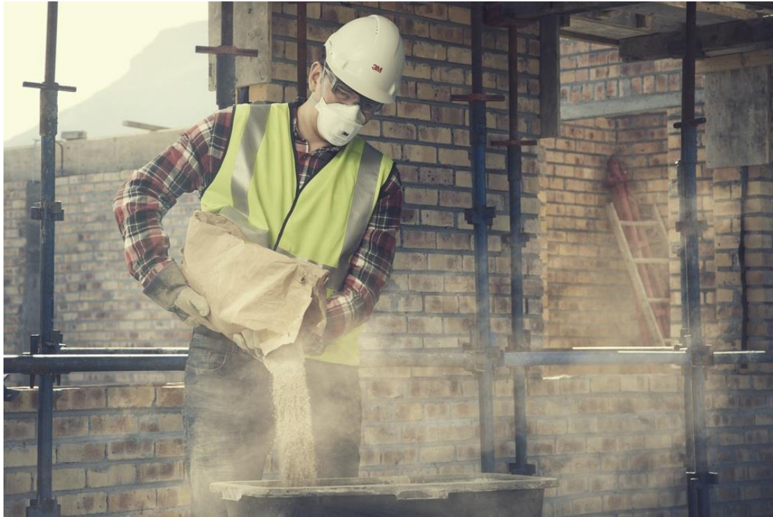
Εικόνα 58: Εργασία που παράγει σκόνη πυριτίου, με την χρήση του κατάλληλου εξοπλισμού Πηγή: iresearch.co.uk
