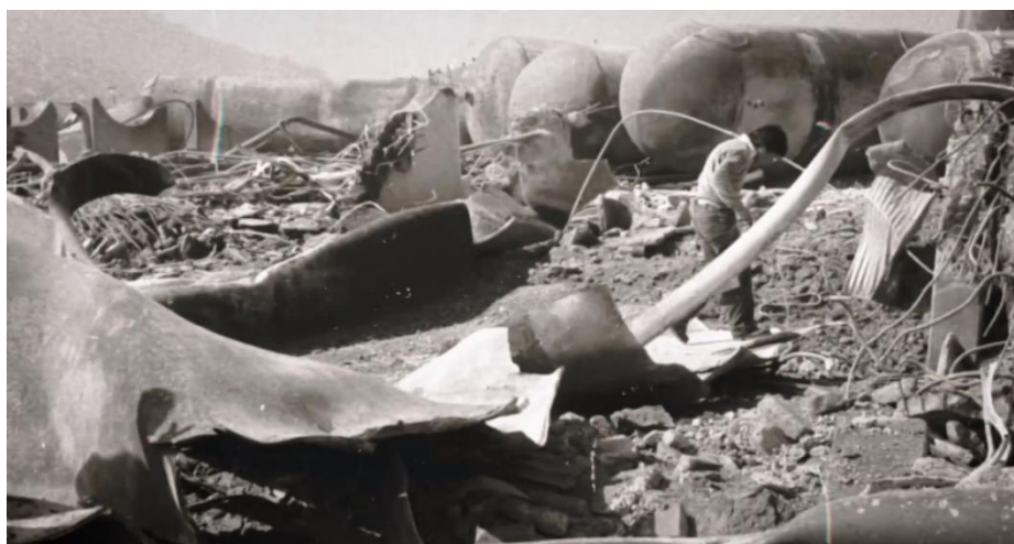
Εικόνα 47: Τα συντρίμμια που απέμειναν από τις εγκαταστάσεις της PEMEX μετά την κατάσβεση των πυρκαγιών (πηγή: www.sprinforma.mx )
