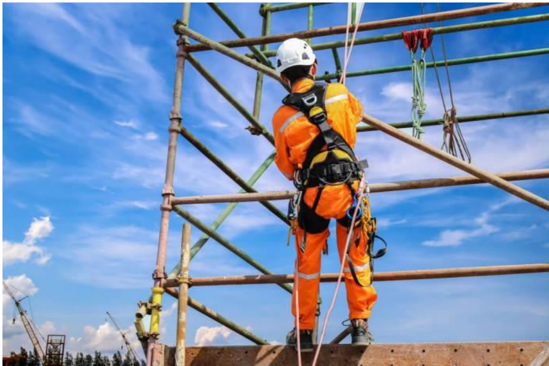
Εικόνα 61: Εργασίες σε σκαλωσιά με την χρήση προστατευτικού εξοπλισμού.
