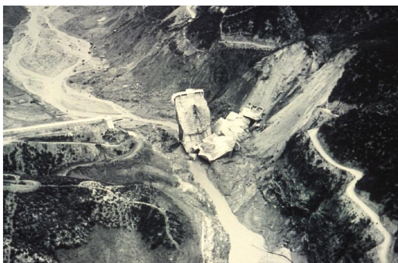
Εικόνα 36: Εναέρια φωτογραφία του φράγματος μετά την αστοχία του (Πηγή: https://damfailures.org/ )
