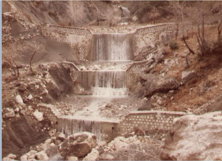
Εικ 1 Φράγματα βαθμιδωσης της κοίτης όπου επιτυγχάνεται α) Σταθεροποίηση της κεντρικής κοίτης β) Εξασφάλιση παροχετευτικής ικανότητας
