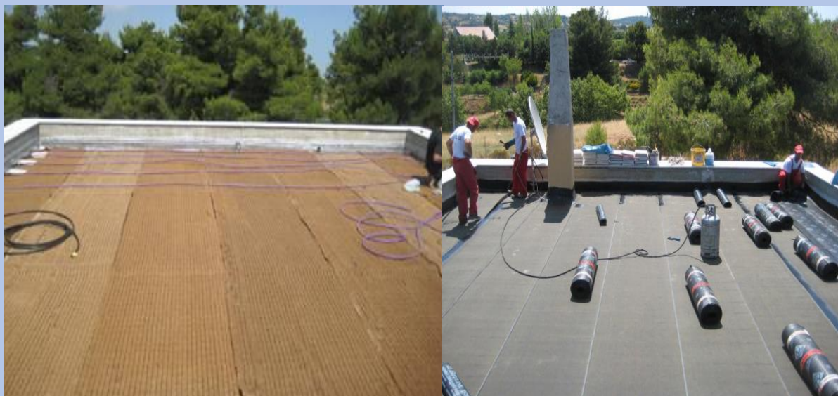
Εικ.12 Μόνωση της επιφάνειας πριν την εγκατάσταση υποστρώματος ανάπτυξης των φυτών
