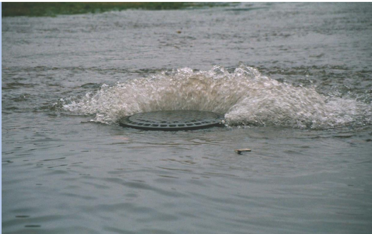
Εικ. 2 Αδυναμία δικτύου ομβρίων να παραλάβει την αστική απορροή μετά από συμβάν ακραίας βροχόπτωσης.
