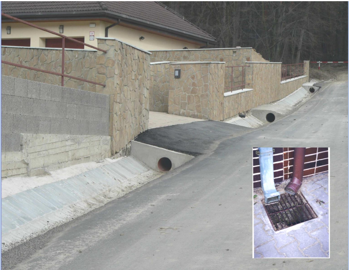
Εικ 1 Χαρακτηριστική εικόνα ανθρωπογενούς στεγανοποίησης του εδάφους. Στο επάνω δεξιά τμήμα της εικόνας διακρίνεται συστάδα δένδρων από παρακείμενη δασική έκταση
