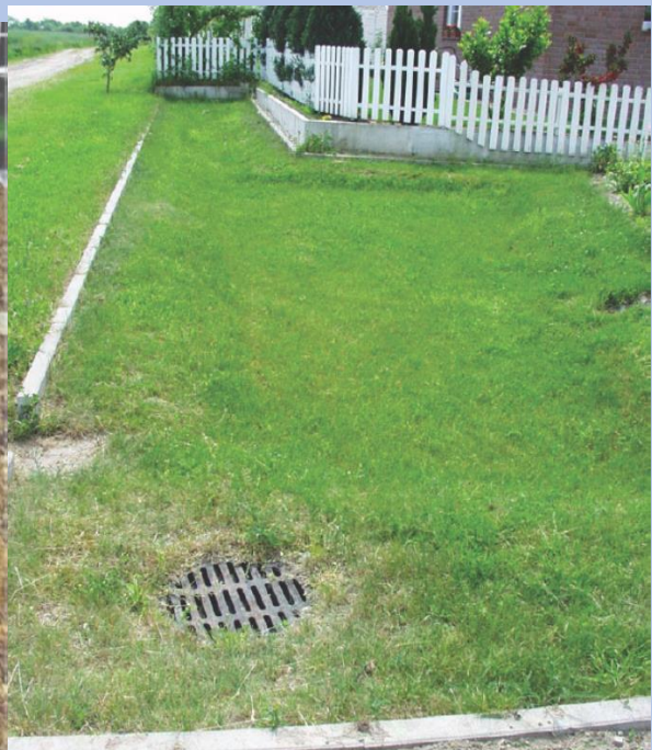
Εικ 19 Φυτοκαλυμμένη επιφάνεια διήθησης που παραλαμβάνει την απορροή κατοικημένης περιοχής α) κατά την κατασκευή και β) μετά το πέρας κατασκευής. Στην εικόνα α) επισημαίνονται το σημείο εισόδου (δεξιά) και η υπερχειλίση (κάτω αριστερά).
