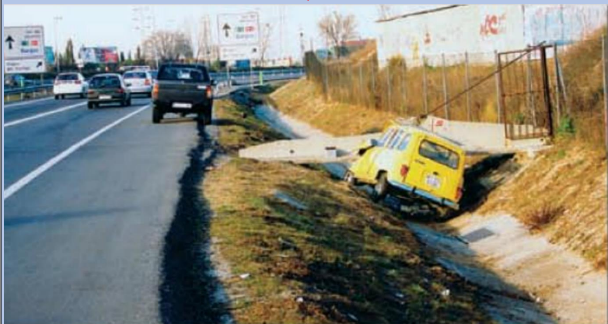
Εικ. 21 Συμβατική επενδεδυμένη τάφρος ομβρίων υδάτων πλησίον οδού (αύξηση σοβαρότητας ατυχημάτων).
