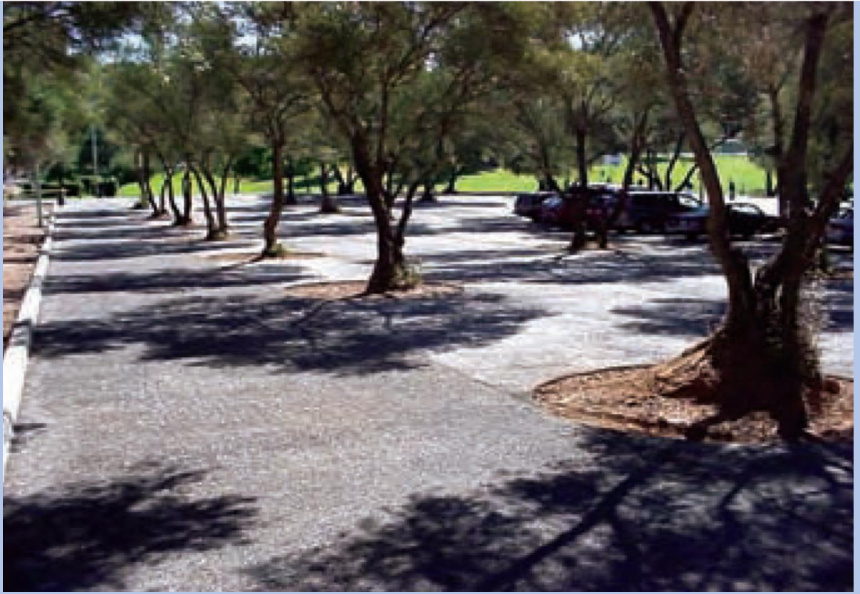
Εικ. 9 Το υδατοπερατό σκυρόδεμα επιτρέποντας την κατείσδυση νερού στο έδαφος, συμβάλλει στην ανάπτυξη δένδρων μειώνοντας ή εξαλείφοντας την ανάγκη άρδευσής τους.
