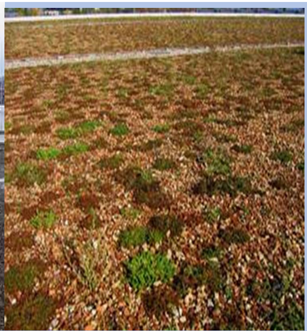
Εικ. 13 Υδροσπορά σε ταράτσα (α) έναρξη φυτρώματος σε εκτατικού τύπου πράσινη στέγη (β)
