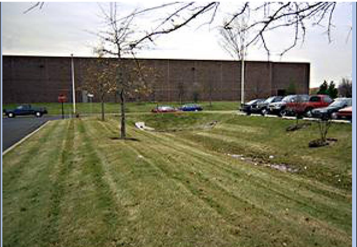
Εικ 20 Φυτοκαλυμμένη επιφάνεια διήθησης που παραλαμβάνει την απορροή χώρου στάθμευσης.
