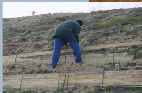
Εικ 5 Μέθοδοι bio-engineering - Εναλλακτικές μέθοδοι εγκατάστασης βλάστησης με ταυτόχρονη χρήση ξύλινων κατασκευών και μοσχευμάτων ( Tamarix sp. , Salix sp. , Populus nigra κλπ)
