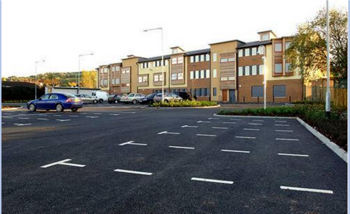
Εικ 6 Εφαρμογή πορώδους ασφάλτου σε χώρο στάθμευσης αυτοκινήτων.
