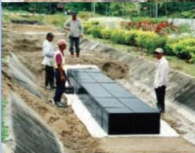
Εικ. 24 Εργασίες σε υφιστάμενη τάφρο για τη μετατροπή σε λεκάνη διήθησης..
