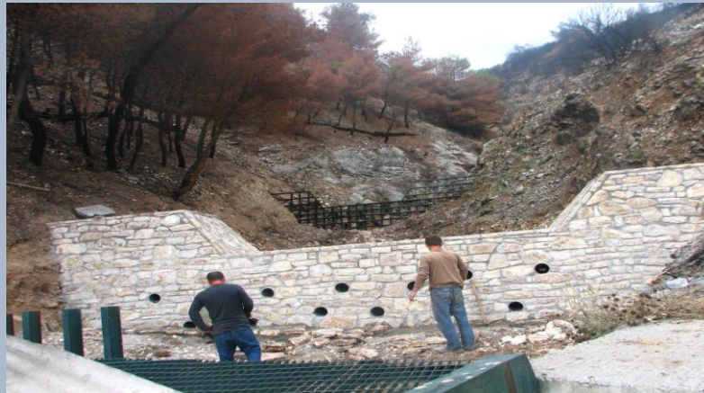
Εικ 2 Φράγματα συγκράτησης φερτών υλικών
