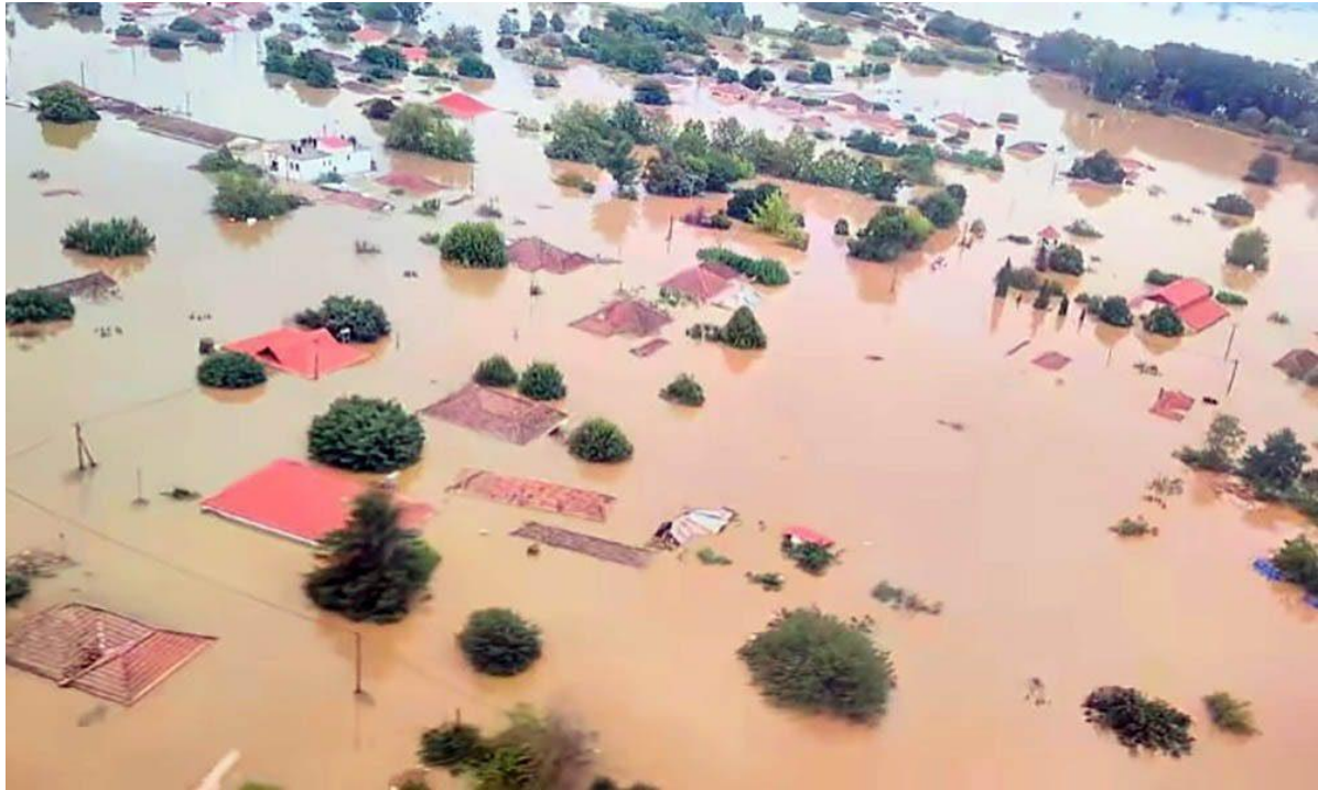
Εικόνα 41. Αεροφωτογραφία από τις πλημμύρες στην Θεσσαλία που προκλήθηκαν από το ακραίο καιρικό φαινόμενο Daniel τον Σεπτέμβριο του 2023 (πηγή: https://kosmoslarissa.gr/ )
